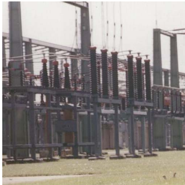
Abb. 1.3: Umspannwerk Südost/Johannesberg, NW-Bereich. Im Vordergrund rechts sind 2 Ziesel zu sehen.
