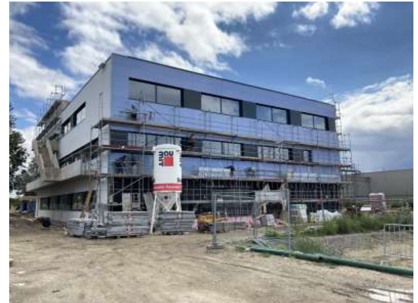
Betriebsgebäude Biomay, Quelle: Wien 3420 AG
